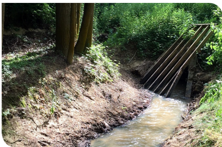
L'entrée du barrage sur le ru de Sinotte.
