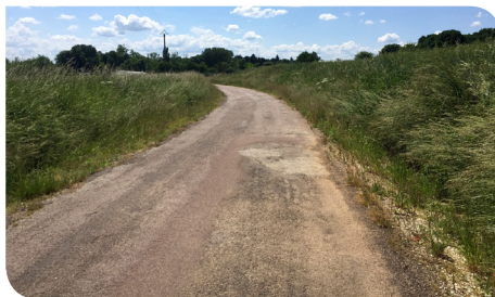
La rue aux vaches avant travaux
