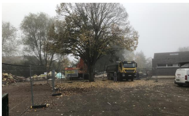
La cantine actuelle a été démolie
