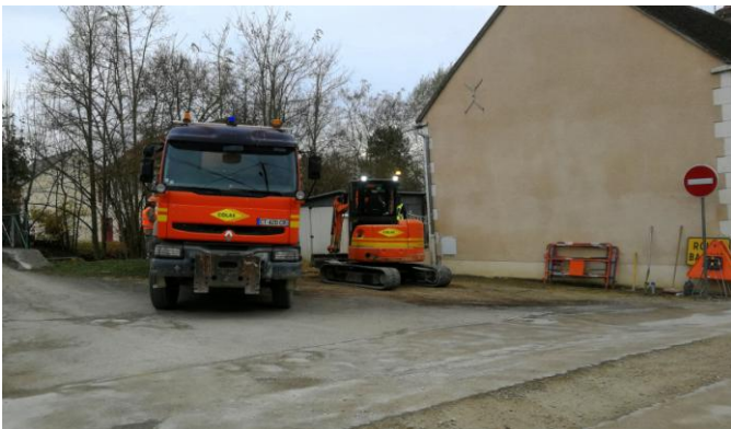
Travaux Grande Rue
