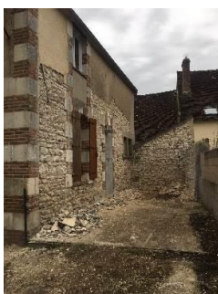
Façade du bar des Trois Cailloux (côté cour)
